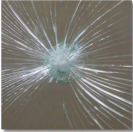
合わせガラスの割れ方
